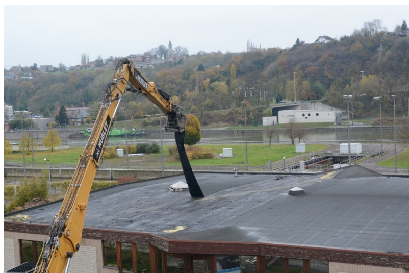
Recyclage sur le chantier lors d'une réaffectation
